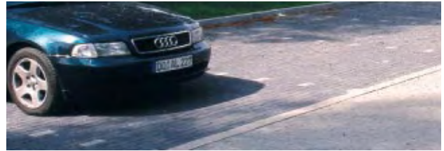
Flächenversickerung (Durchlässige Beläge)
