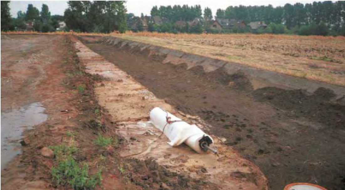
Kanalanschlussschacht mit Rückstausicherung (Mulden-Rigolen-System im Bau)
