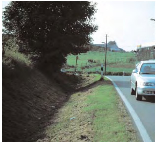
Konventionelle Straßenentwässerung über Rasenrinne (Straßenseitengraben) – stabiler Aufwuchs der Vegetation durch regelmäßige Pflege gewährleistet
