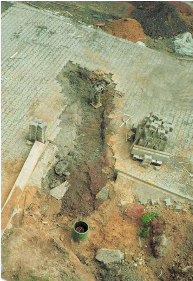
Drosselschacht mit direktem Anschluss an Kanal (Oberhalb der Rückstauenebene) im Bau
