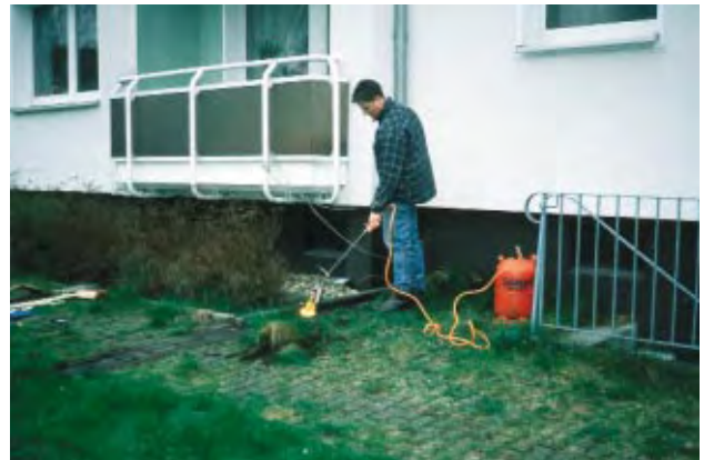
Abflammen des Pflanzenaufwuchses in den Fugen
