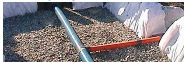
Direktbeschichtete unterirdische Versickerungsanlagen
