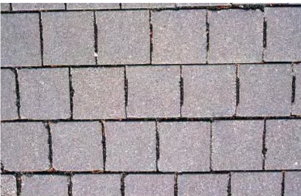
Sickerfugenpflaster nach der Reinigung
