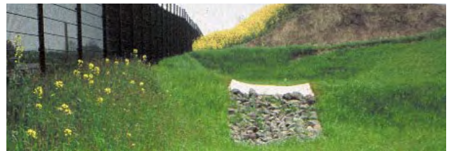
Mulden-Rigolenversickerung / Mulden-Rigolen-System
