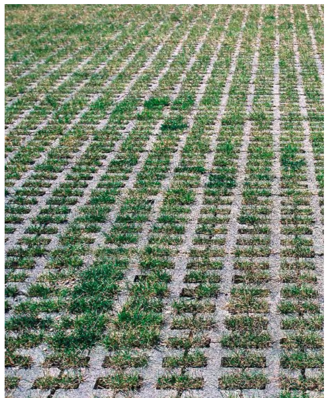
Stellplatzanlage in Rasenkammerstein
