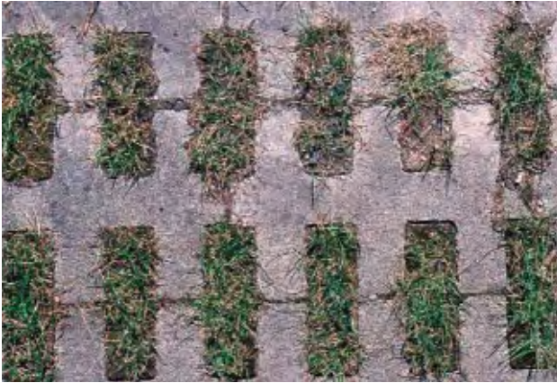
Rasenkammerstein – normaler Bewuchs
