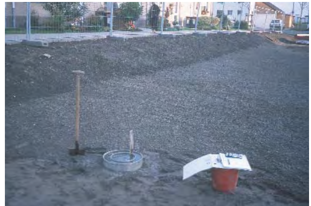
Messung der Versickerungsleistung nach erforderlichem Bodenaustausch
