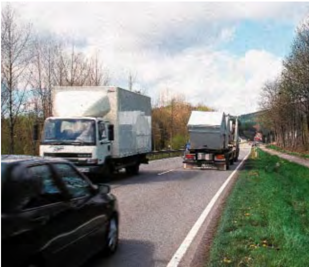
Straßenentwässerung über Seitenstreifen
