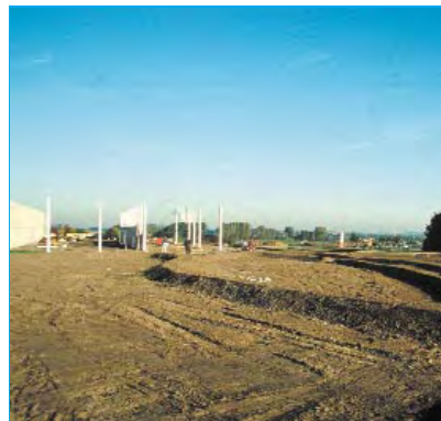
Erstellung Muldenwälle auf neuprofilierter Versickerungsfläche
