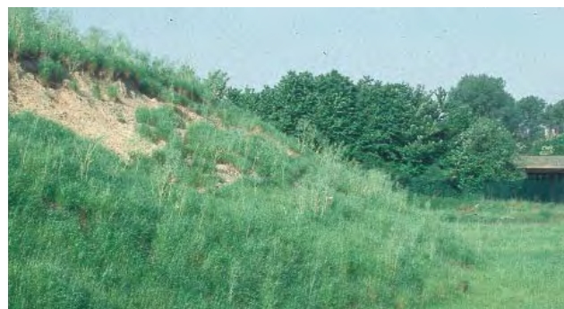
Mulden-Rigole durch unzureichend gesicherte Böschung geschädigt
