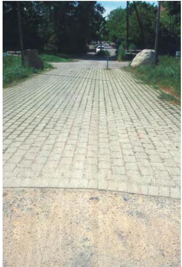
Erhöhte Sedimenteinträge in Rasenfugen bei Kombination mit wassergebundener Decke
