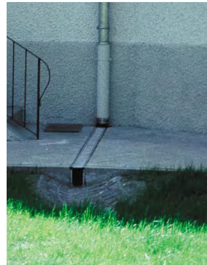
Ableitung vom Gebäude
