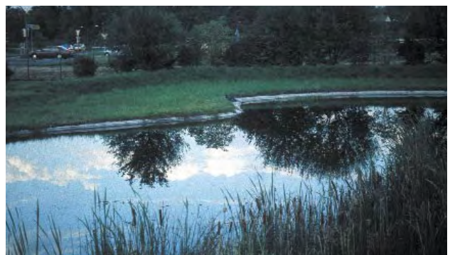
Regenwassergespeicher Löschwasserteich mit Versickerungszone
