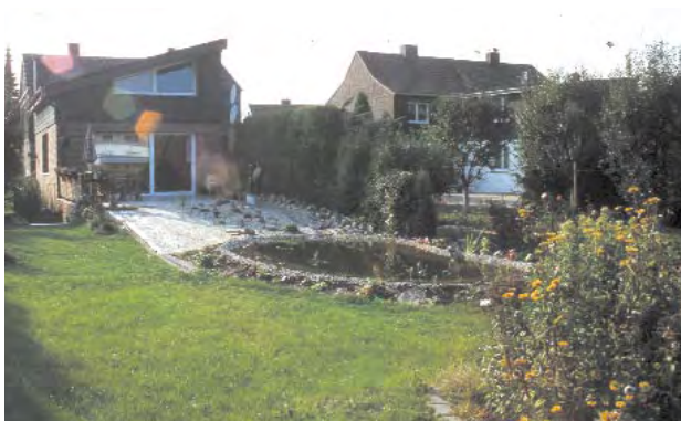
Teich mit Überlauf in Versickerungsmulde – Einfamilienhaus
