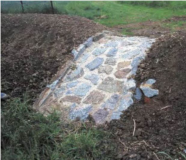
Notüberlauf aus Wasserbausteinen in Beton nach der Fertigstellung
