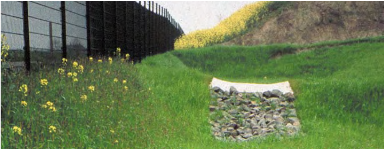
Überlauf einer Mulden-Rigolen-Kaskade
