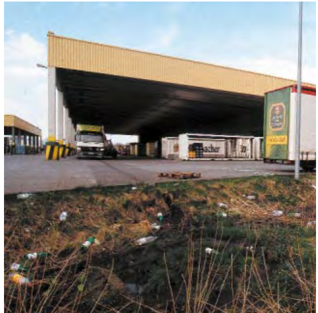
Zustand nach sechs Jahren Betrieb
