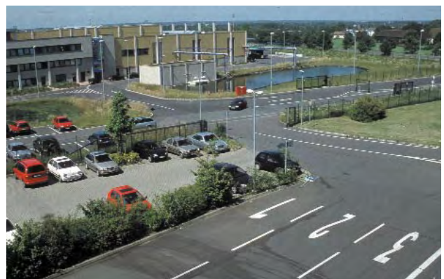
Regenwassergespeister Löschwasserteich mit umlaufender Versickerungszone
