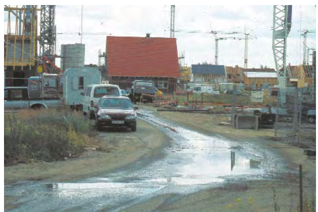
Mittelrinne - Baustraße in Schwarzdecke
