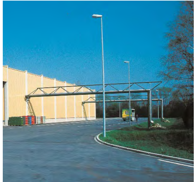
Rohrbrücke (Unterdruckentwässerungssystem)
