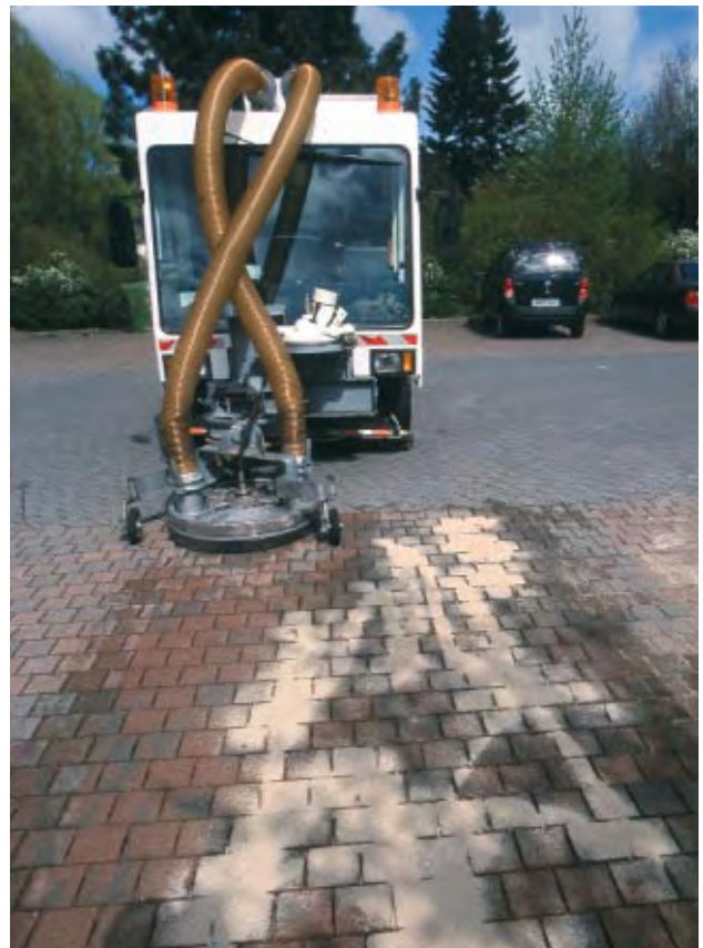
Neuverfugen gereinigten Sickerfugenpflasters
