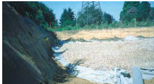
Großflächige Mulden-Rigole im Bau
