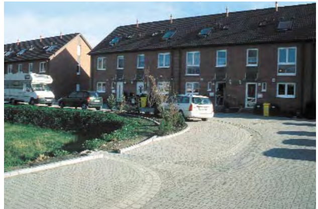
Ableitungsdetail Mittelrinne in Versickerungsmulde
