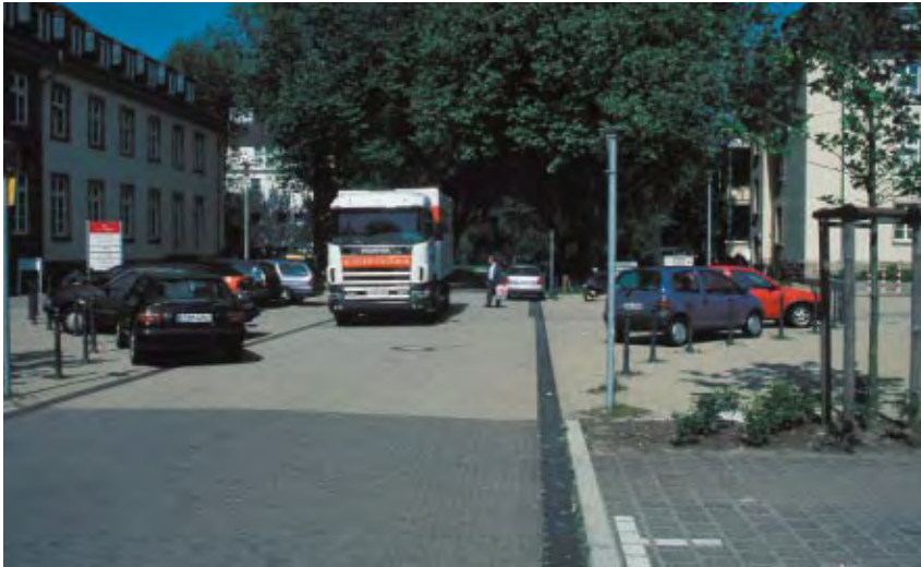
Gedeckte Kastenrinne – Straßenentwässerung
