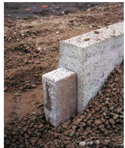
Zwischenstein garantiert ausreichende Lückenbreite und glatte, gut zu reinigende Sohlfläche
