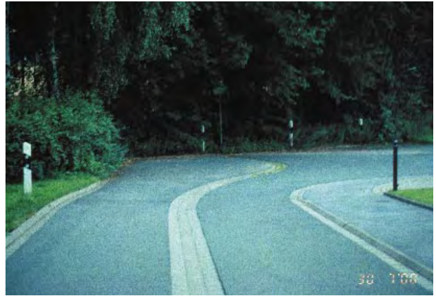
Mittelrinne aus Betonpflaster - Separationsprinzip
