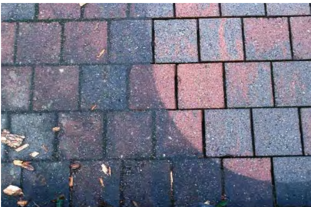
Verschmutztes / gereinigtes Sickerfugenpflaster
