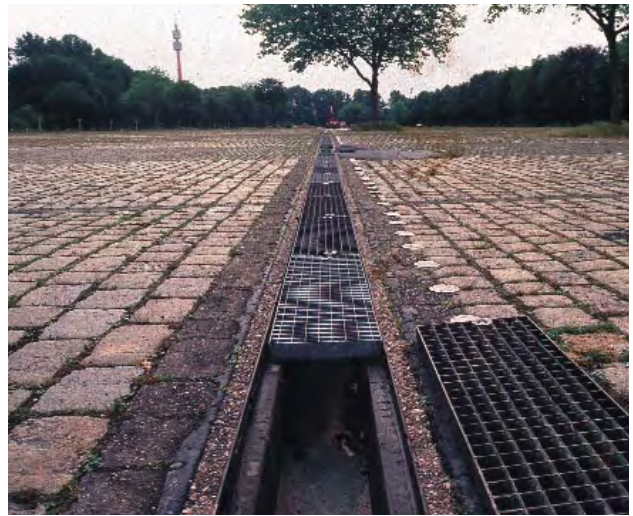
Gereinigter Rinnenquerschnitt
