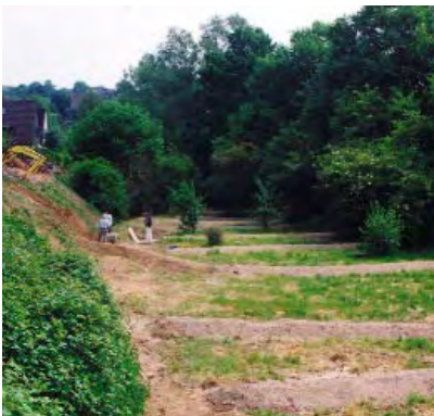
Erstellung Muldenwälle auf vorhandener Vegetationsfläche (Muldenkaskade)
