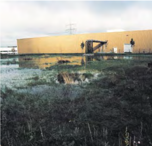
Rohrbrücken zur offenen Ableitung des Niederschlagswassers (Freispiegelleitung)
