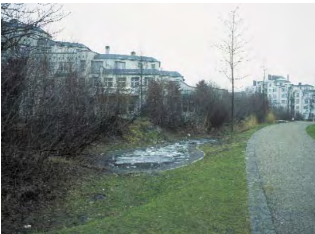
Versickerungsmulde mit integriertem Teich im Winter bei Frost
