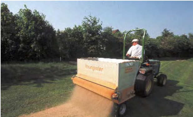
Besanden der Versickerungsfläche
