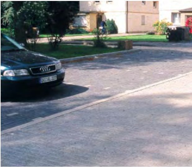
Stellplatzanlage mit porösem Betonpflaster
