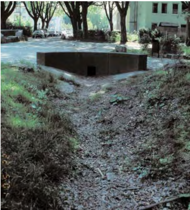
Verlust Vegetationsdecke durch Laubablagerung
