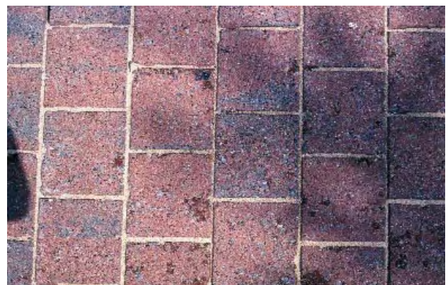
Sickerfugenpflaster gereinigt und neu verfugt
