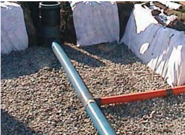
Dränrohr mit Drosselschacht in flächigen Mulden-Rigolen
