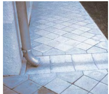
Wasserdichter Rinnenanschluß mit Spezialformstein
